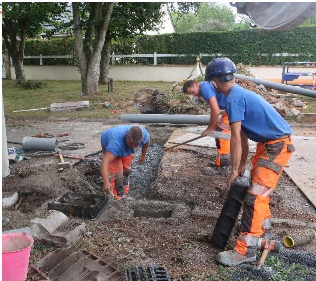
Suite aux inondations des maisons des lotissements Auvray la Bataille et du Clos de l'église, des travaux complémentaires au réseau d'eau pluvial existant sont entrepris pour absorber les afflux d'eau.
